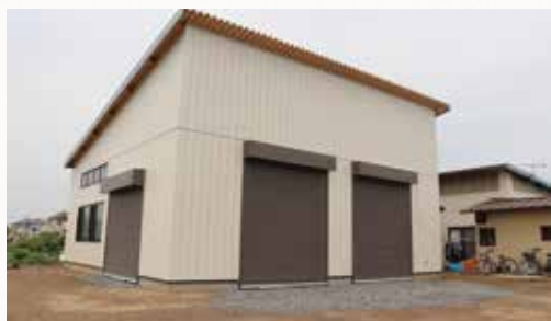
↑増築中の作業場兼休憩所
