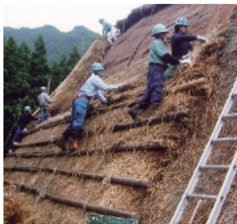
合掌造りの屋根を葺き替える作業は、春と秋に行われる（写真上）
