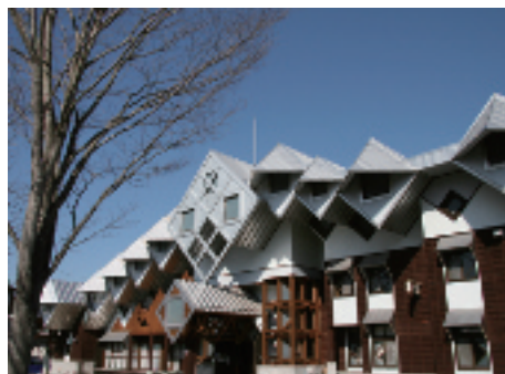
小国の伝統的構法「置き屋根」をヒントに「ボックス梁」という新しい構法の建物で作られた木魂館
