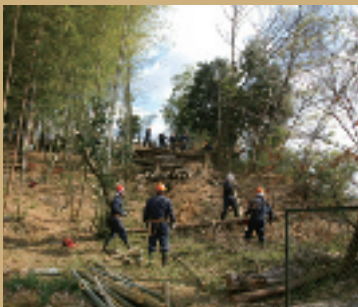
①この日は吉野地方から車で1時間かけ町に。住宅街の危険木処理を行う
