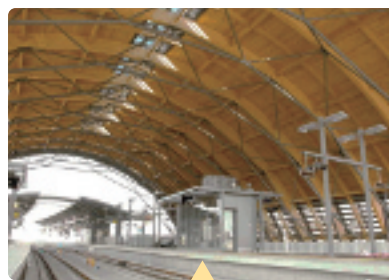
地元の木材を使用した駅舎 (高知駅)
