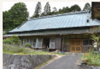
↑築150年の旧家。元々はかやぶき屋根だったが、トタン屋根に改修されている。
